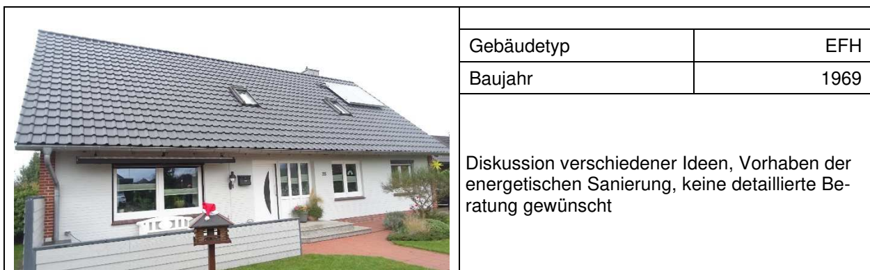
Abbildung 8-5: Gebäudeansicht, Gebäude B
